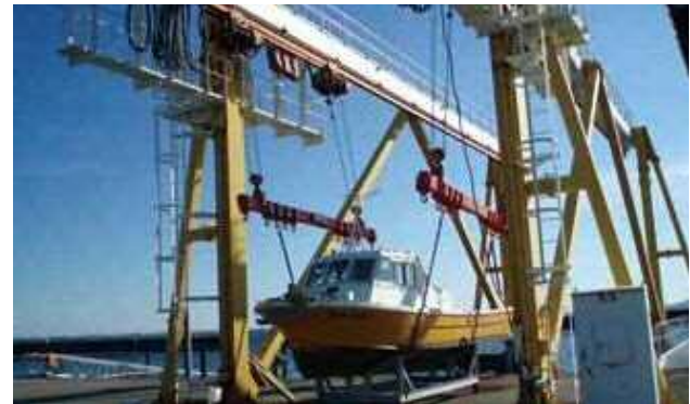
クレーン(9t吊)
